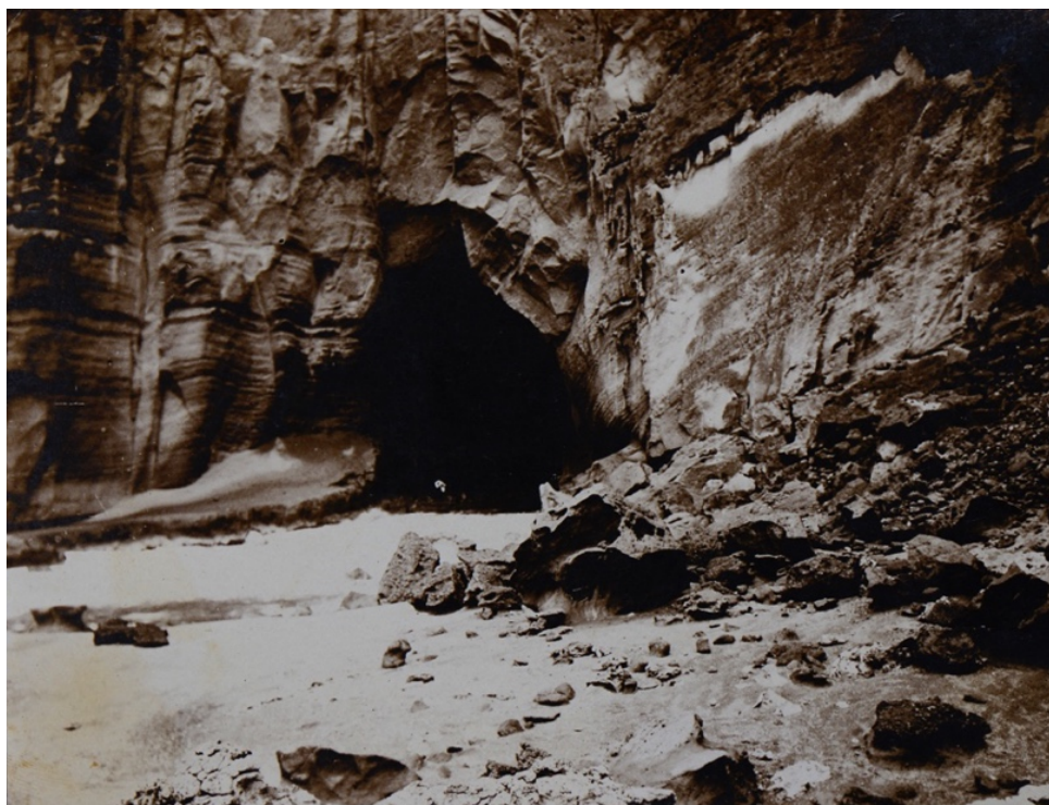
Figura 96: Entrada do Túnel (1916).
