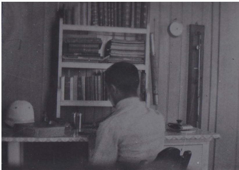
Figura 93: Alojamento dos oficiais (1919).
