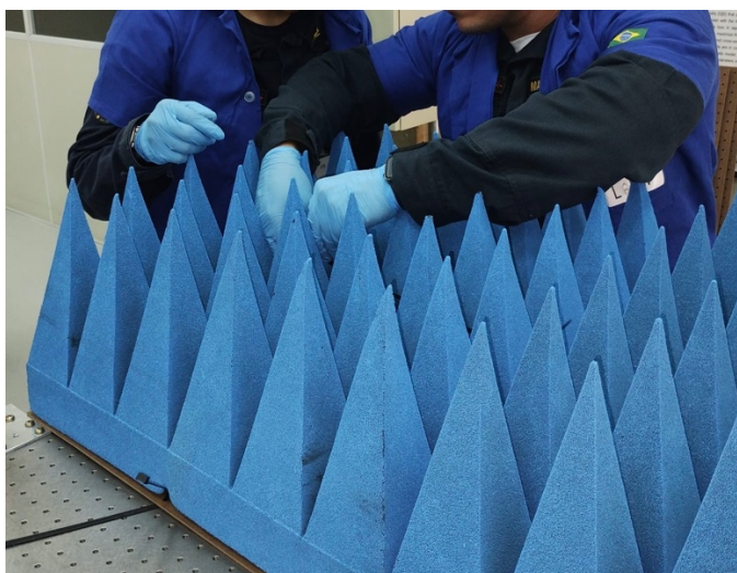
Figura 22 - Absorvedores sendo fixados nas placas MDF
