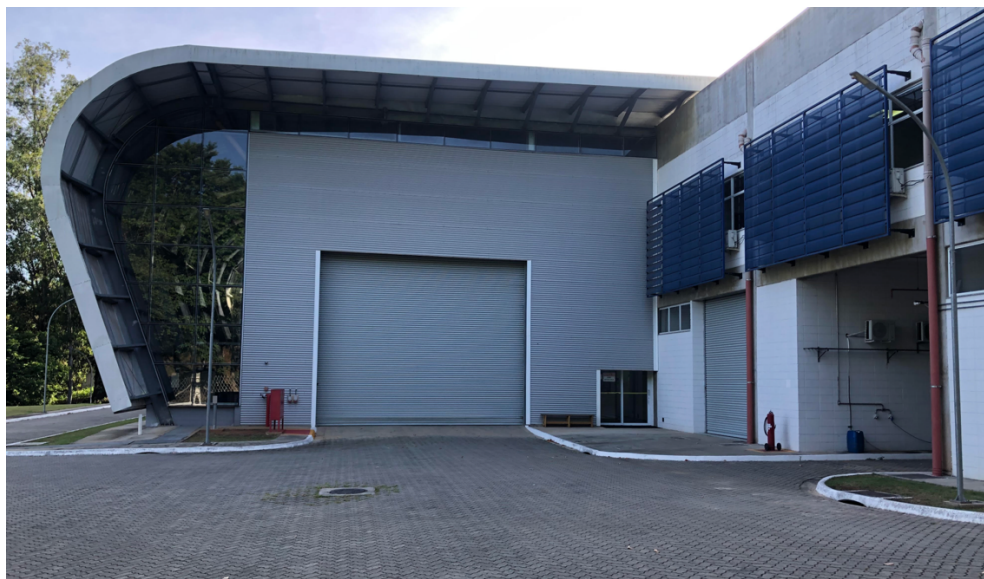
Figura 17 - Prédio do Laboratório de Micro-ondas, Potência e Fotônica
