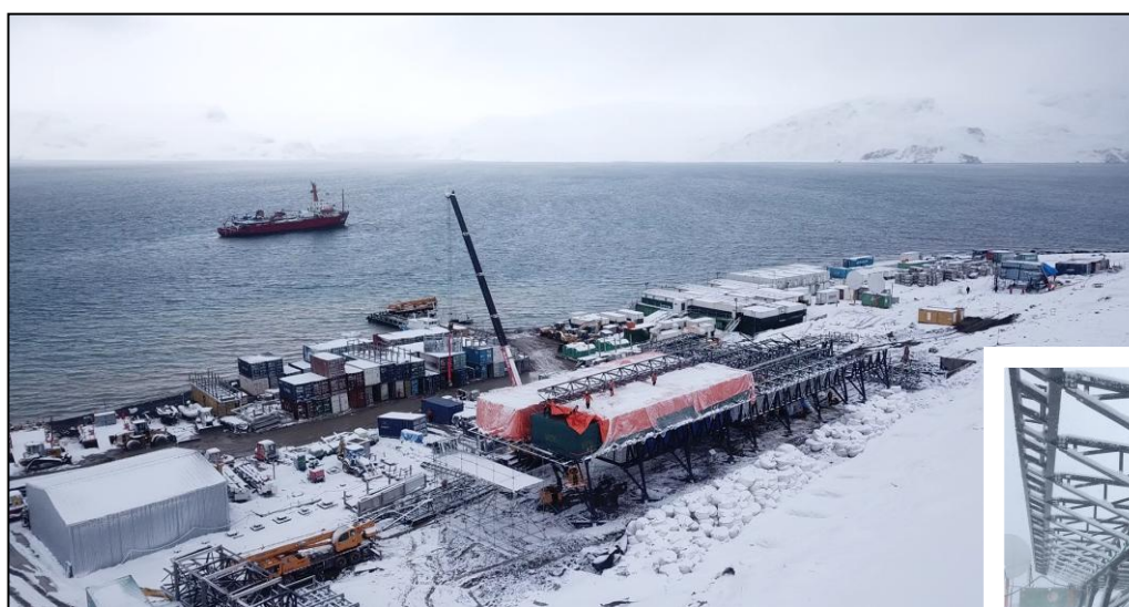
Figura 4.14 – Vista da EACF em construção, Antártica 2017-2018.
