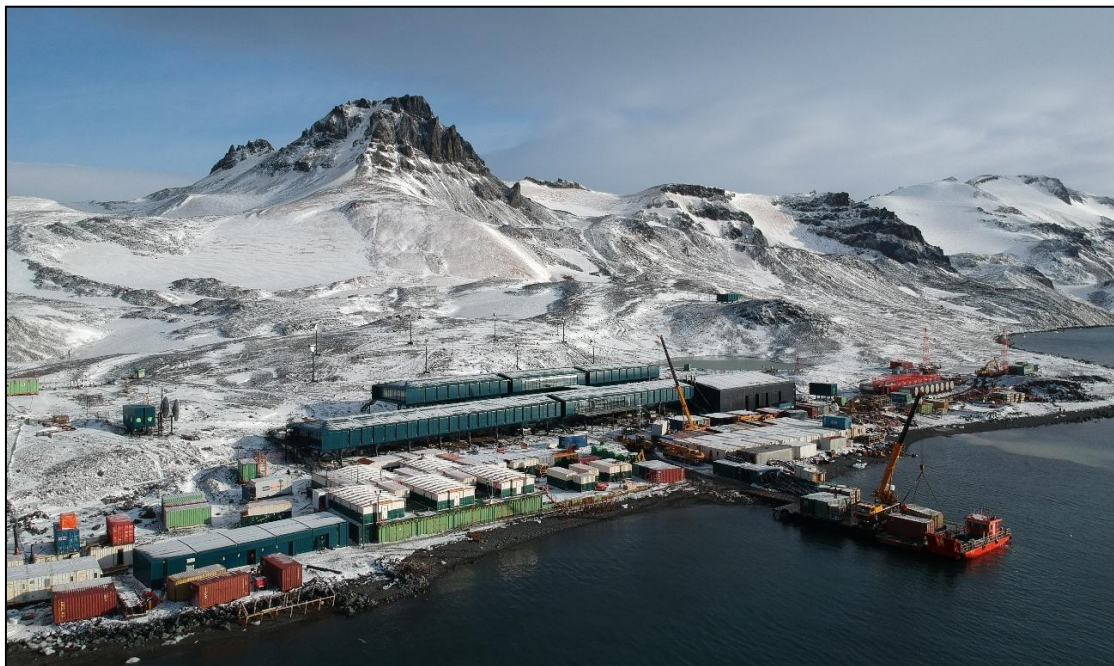
Figura 4.15 – Vista da EACF em construção, Antártica 2019.
