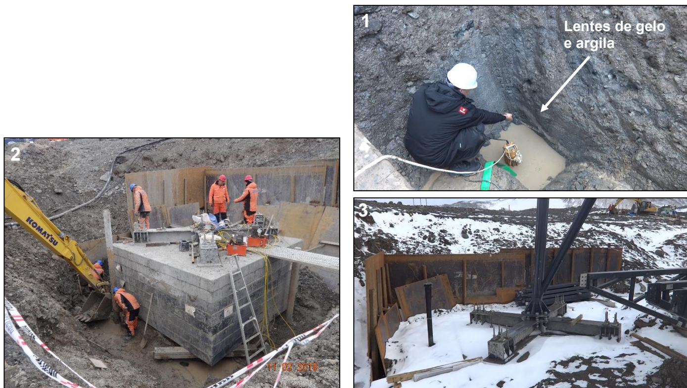
Figura 4.17 – Bloco de fundação reforçado: Lentes de gelo e argila (1); Trabalhos de reforço da fundação (2) e Bloco de fundação pronto para receber a superestrutura (3).
