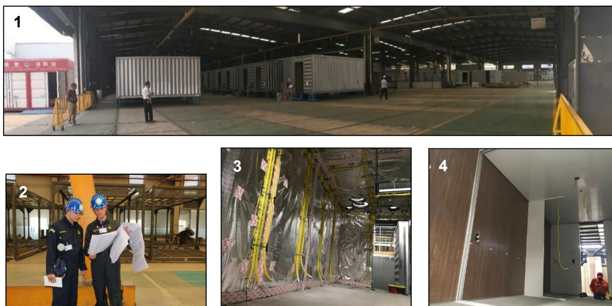
Figura 4.12 – Preparação dos módulos contêineres: Fábrica em Xangai (1); Verificação da execução na fábrica (2); Preparação das instalações internas dos módulos (3 e 4).
