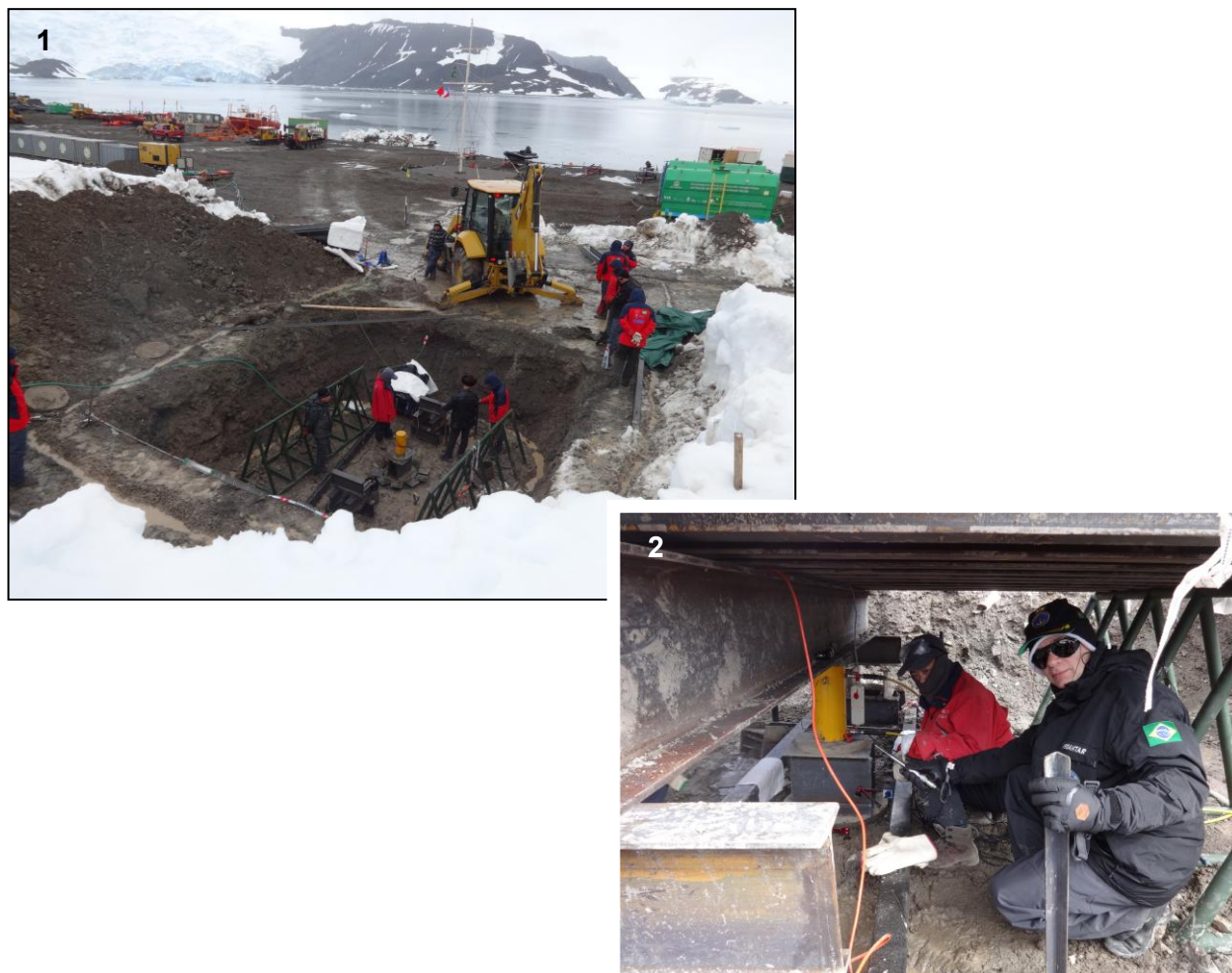
Figura 4.7 – Ensaio de carga em placa sobre solo de fundação (verão antártico 2015 - 2016)
