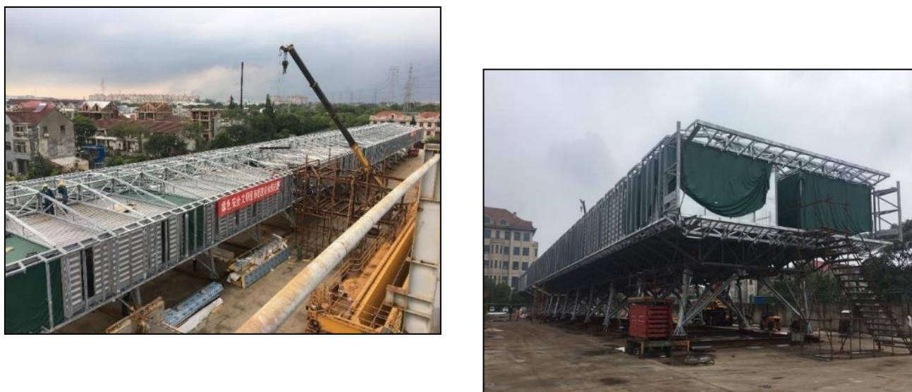
Figura 4.13 – Vistas da pré-montagem da EACF em Xangai, China.
