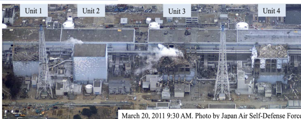
Figura 4 – Danos estruturais nas Unidades 1 a 4 da Central Nuclear de Fukushima Daiichi.
