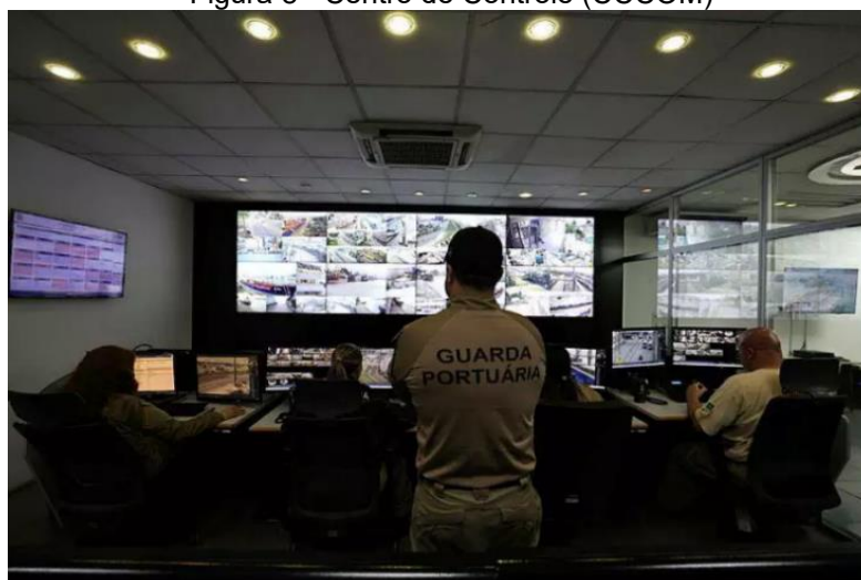
Figura 8 - Centro de Controle (CCCOM)
