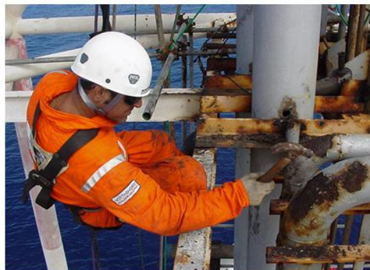
Figura 2.2 – Escalador industrial avaliando dano em tubulação
