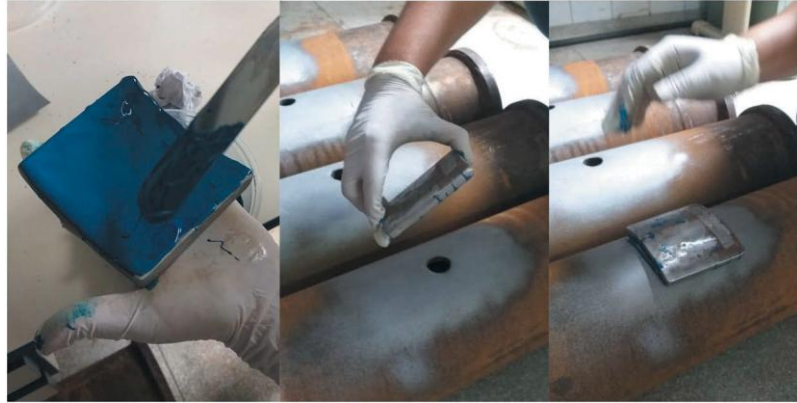
Figura 3.2 - Colagem dos patches metálicos.
