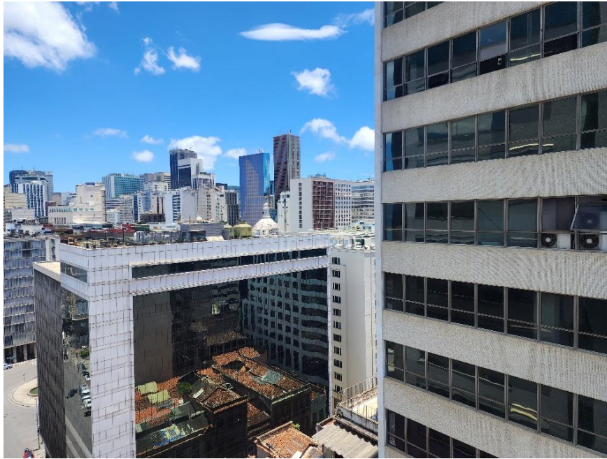
Figura 61: Vista das janelas da fachada oeste.
