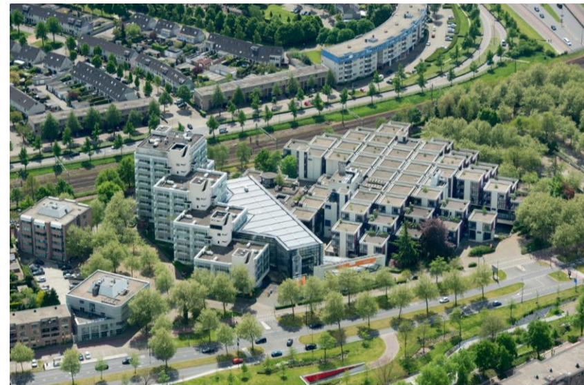
Figura 6: Vista externa do edifício de escritórios Centraal Beheer , Holanda.
