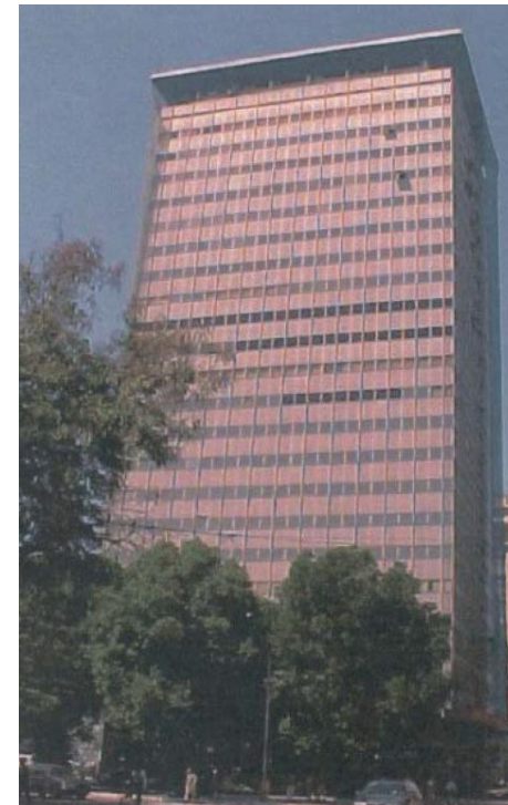
Figura 22: Vista do Edifício Barão de Ladário (EdBL) original.
