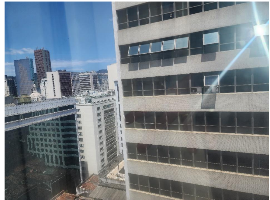
Figura 63: Efeito de ofuscamento no edifício localizado em frente a fachada oeste.
