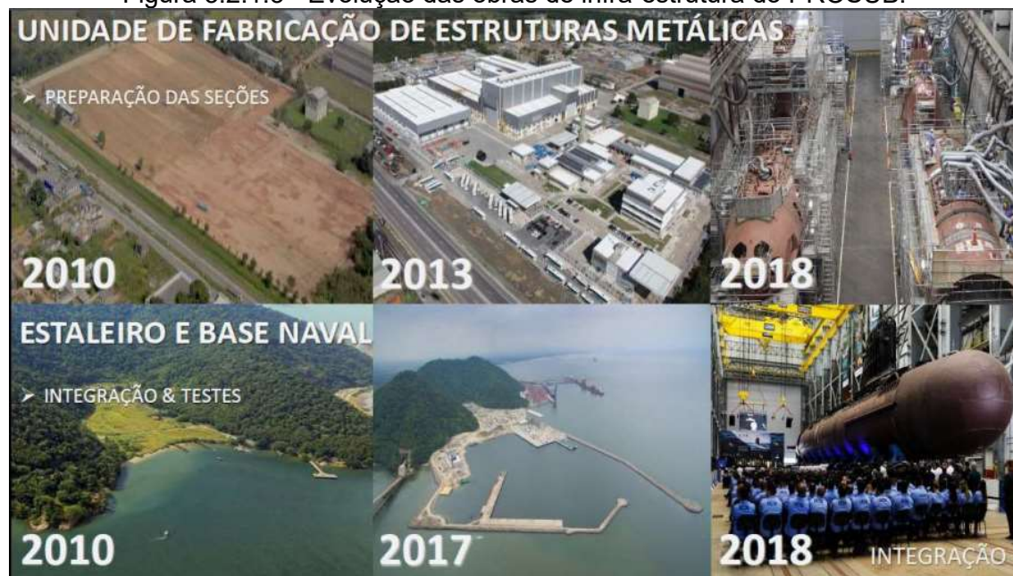
Figura 3.2.1.3 - Evolução das obras de infra-estrutura do PROSUB.
