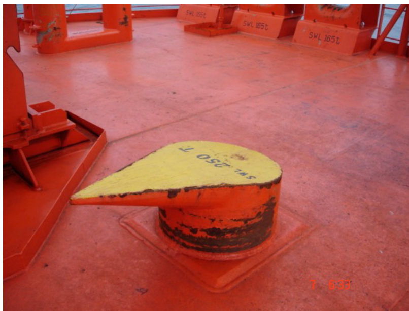
Figura 14: Cabeço para reboque do DPST Navion Stavanger. Fonte: PETROBRAS INSPECTION REPORT, 2006.
