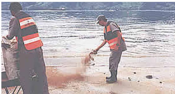
Figura 16: Aplicação de turfa vegetal
