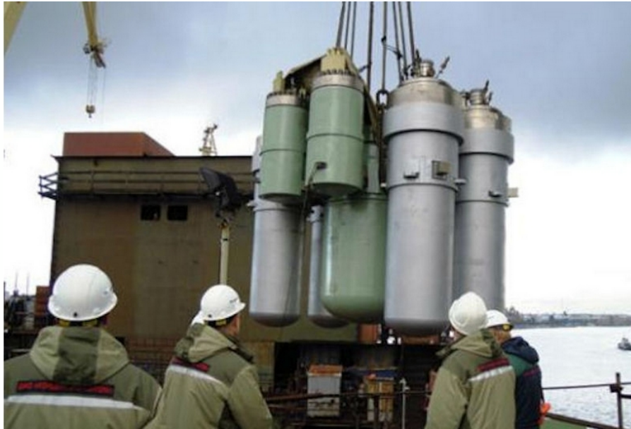
Figura 1.3 - SMR russo KLT-40S sendo embarcado à bordo do navio Akademik Lomonosov . Retirado do sítio globalsecurity.org em 2 abr. 2025.
